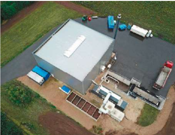
Abbildung 3 Drohnenaufnahme eines Klärschlamm-Trocknungs- und -Verbrennungsstandortes zur Veranschaulichung des geringen Platzbedarfes ©Werkstätten GmbH
