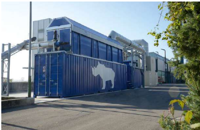
Klärschlamm-trocknung mit einem RHINO® Kommunal 10000 Plus in Plattling (Bayern).
